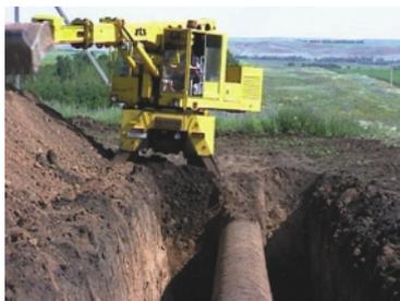
По результатам электрометрического диагностирования, по согласованию с заказчиком, выбираются места для последующей шурфовки и ремонта.
