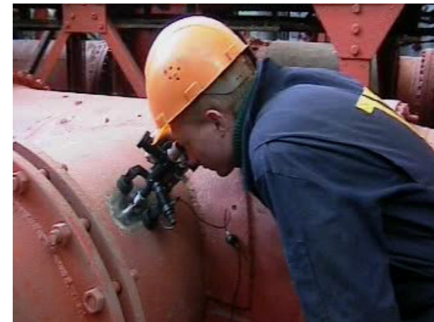
Металлографическое исследование металла действующего оборудования с применением переносных микроскопов
