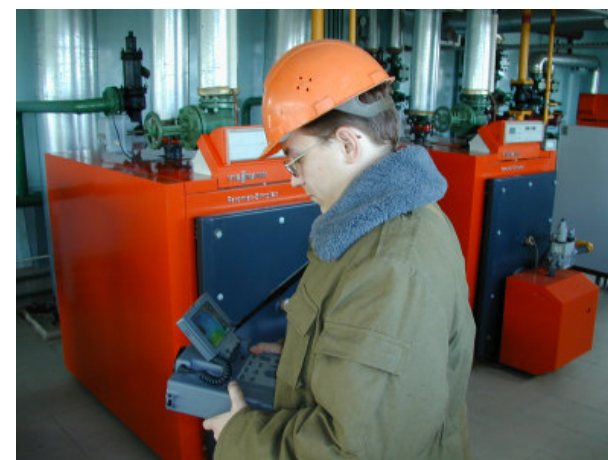
Проведение теплового контроля
