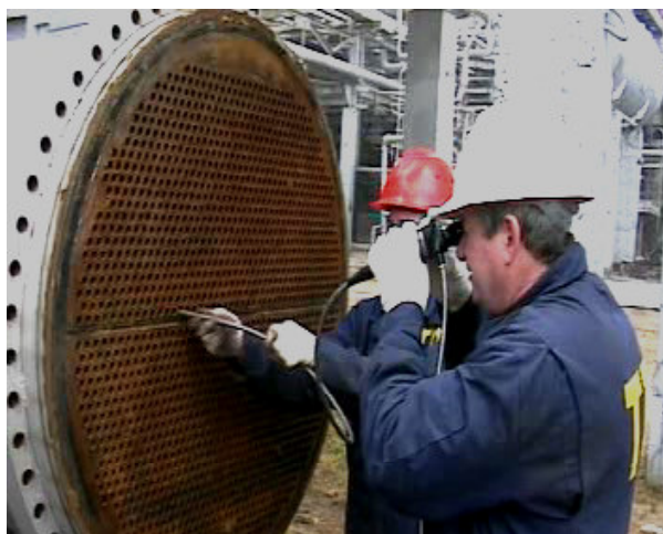
Визуальный и измерительный контроль внутренней поверхности трубок теплообменника
