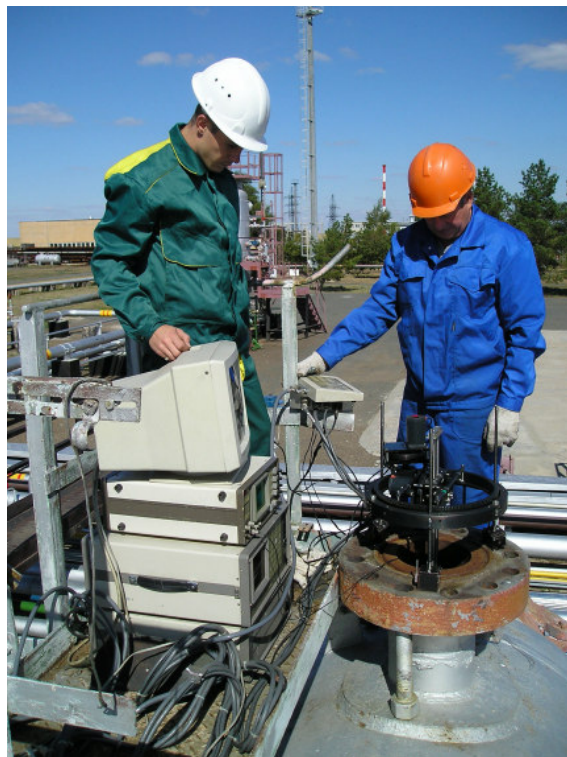
Ультразвуковое сканирование штуцерного узла (УКПГ-10, Оренбурггазпром)
